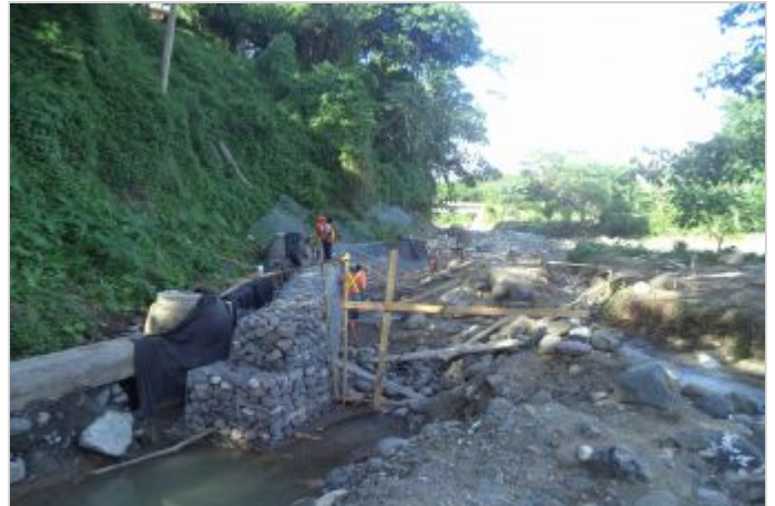
Durante la Obra
