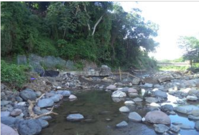
Durante la Obra
