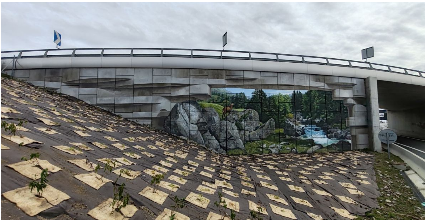
Vue d'ensemble de l'ouvrage
