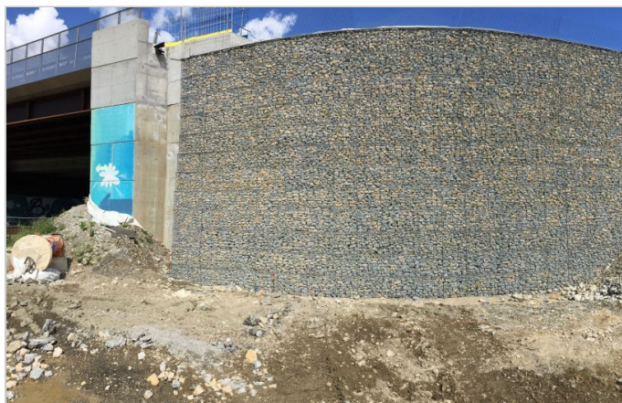
Raccordement du TerraMesh Minéral à l'ouvrage d'art
