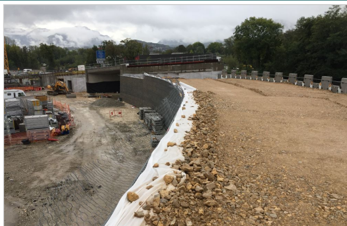
TerraMesh Minéral à gauche et MacRes à droite en cours de réalisation
