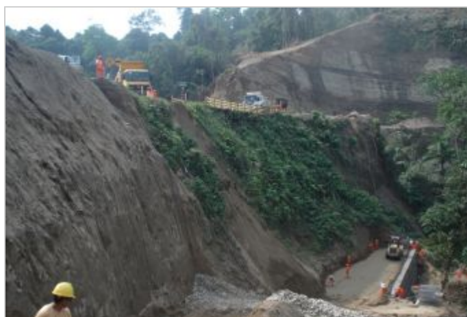
Durante a obra
