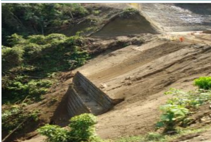
Durante a obra
