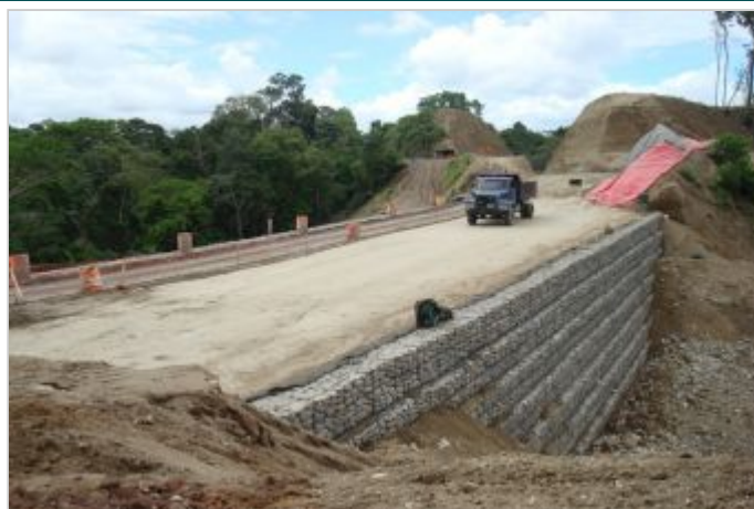
Durante a obra
