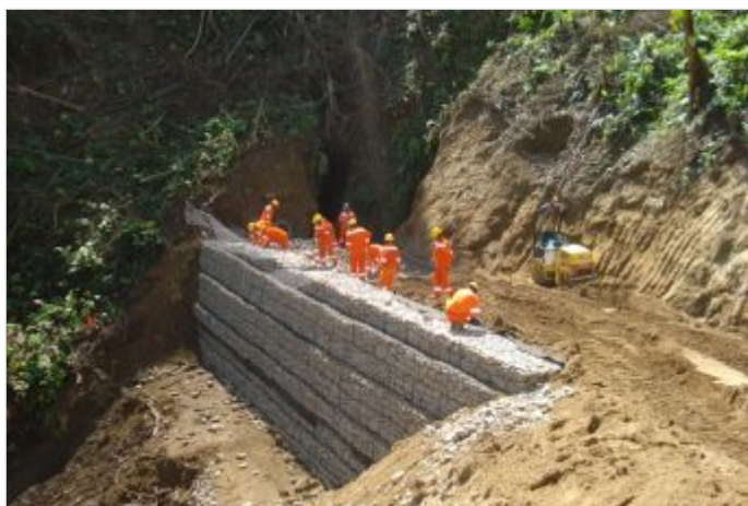
Durante a obra
