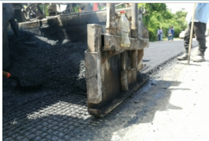
Durante la Obra
