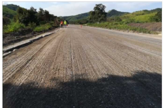
Durante la Obra
