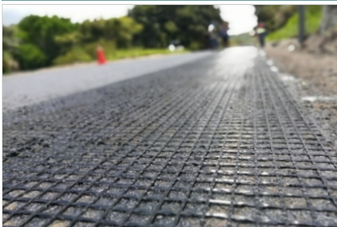
Durante la Obra
