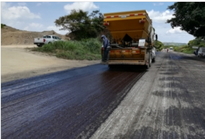
Durante la Obra
