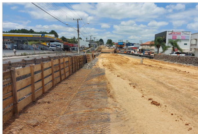
Durante a obra
