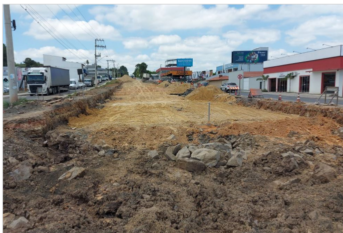
Durante a obra
