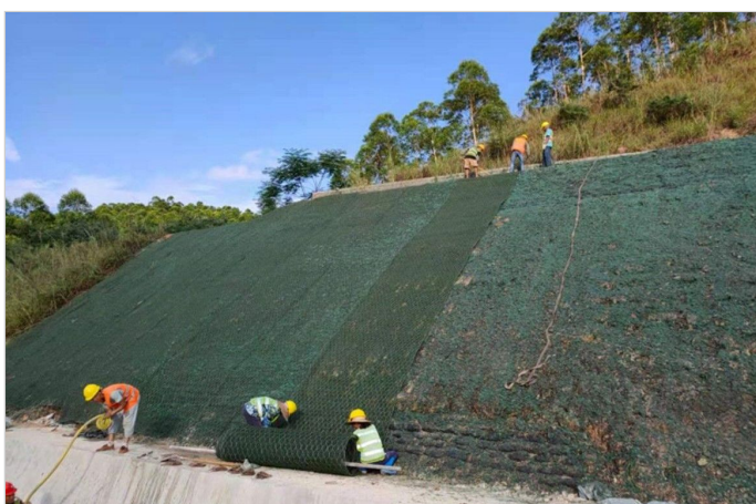
加筋麦克垫施工
