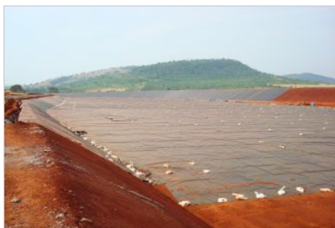
Durante a obra
