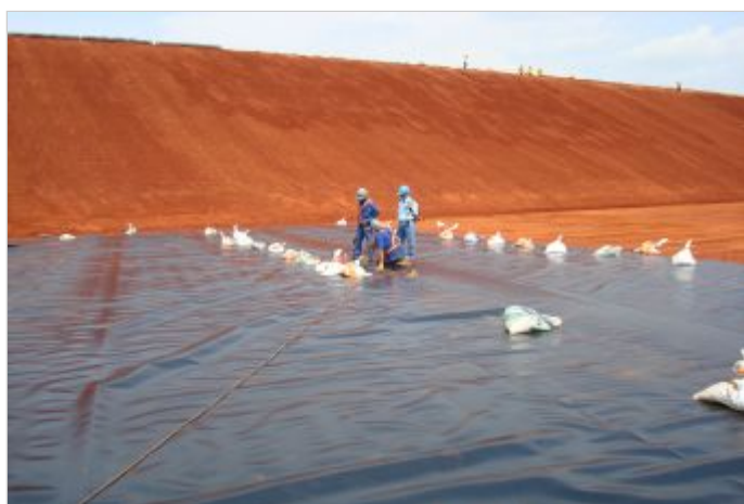
Durante a obra
