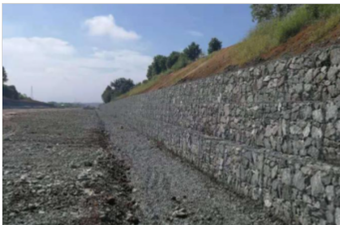
图三：项目竣工照片
