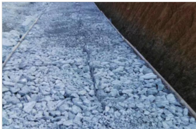
图一：项目施工中
