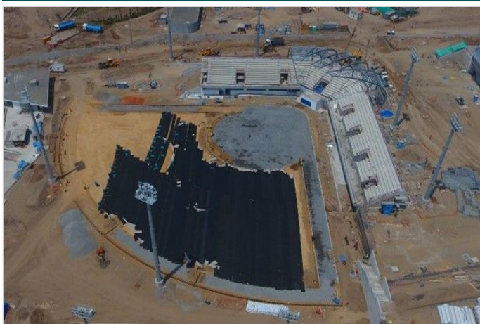
Durante a obra
