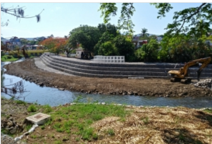
Durante la Obra
