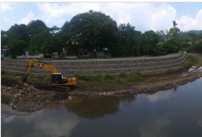
Durante la Obra
