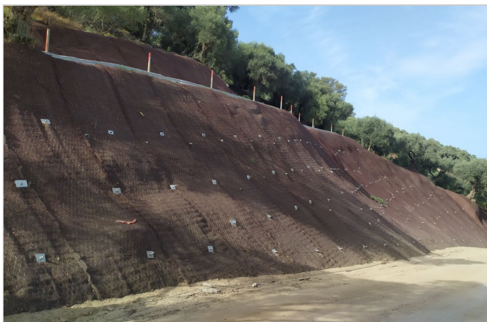
ΤΡΙΣΔΙΑΣΤΑΤΟ ΓΕΩΠΛΕΓΜΑ ΕΠΕΝΔΥΣΗΣ ΠΡΑΝΩΝ ΜΑΣΜΑΤ R1 8127GN ΣΤΗ ΦΑΣΗ ΤΗΣ ΚΑΤΑΣΚΕΥΗΣ
