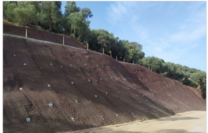
ΤΡΙΣΔΙΑΣΤΑΤΟ ΓΕΩΠΛΕΓΜΑ ΕΠΕΝΔΥΣΗΣ ΠΡΑΝΩΝ MACMAT R1 8127GN ΣΤΗ ΦΑΣΗ ΤΗΣ ΚΑΤΑΣΚΕΥΗΣ
