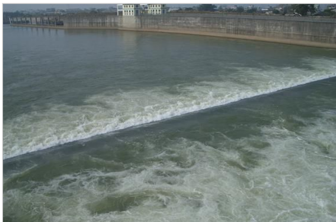
改造后的消力池和海漫的消能效果
