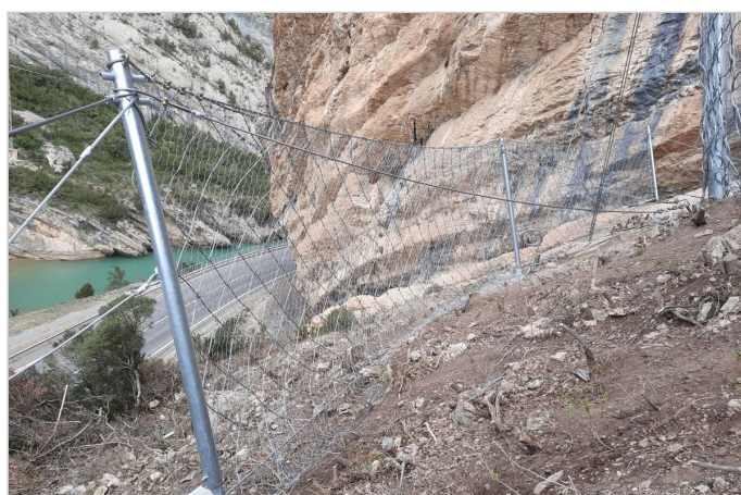
Vista Barrera RB 750 y carretera
