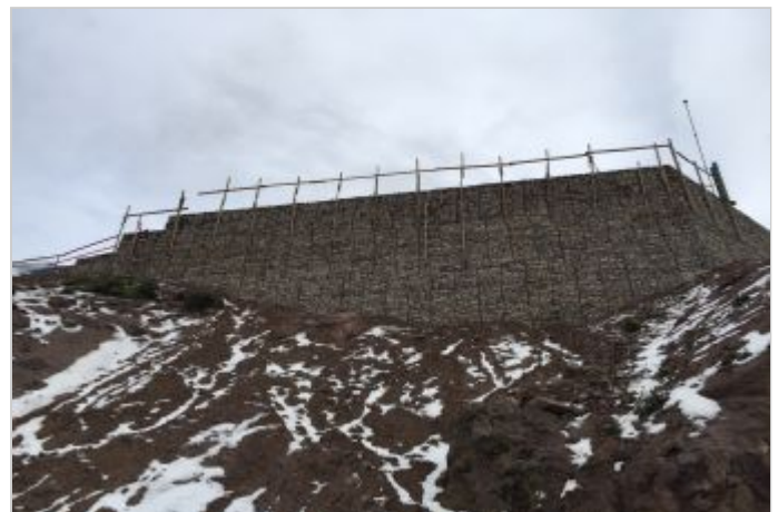
Durante la Obra
