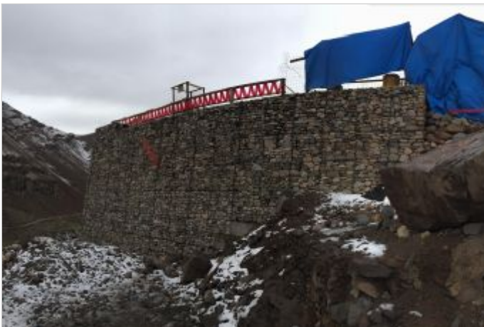
Durante la Obra
