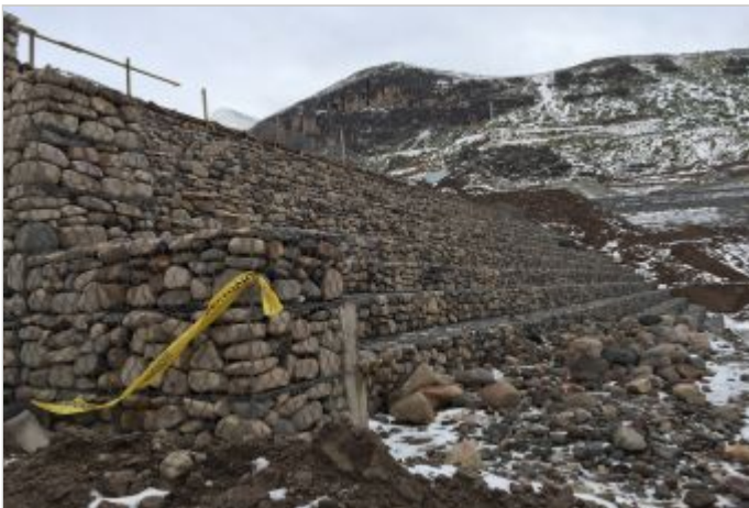
Durante la Obra
