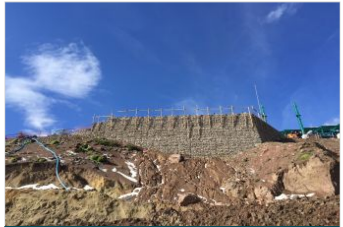
Durante la Obra
