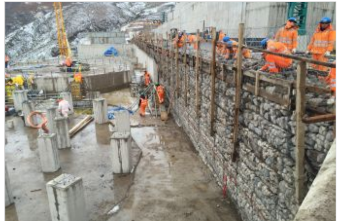
Durante la Obra
