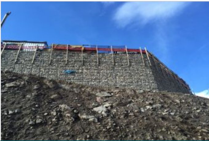
Durante la Obra
