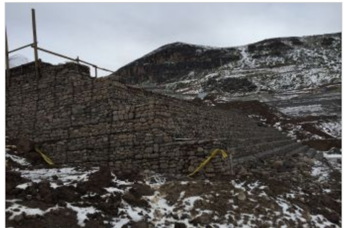
Durante la Obra
