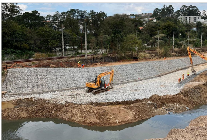
Durante a obra
