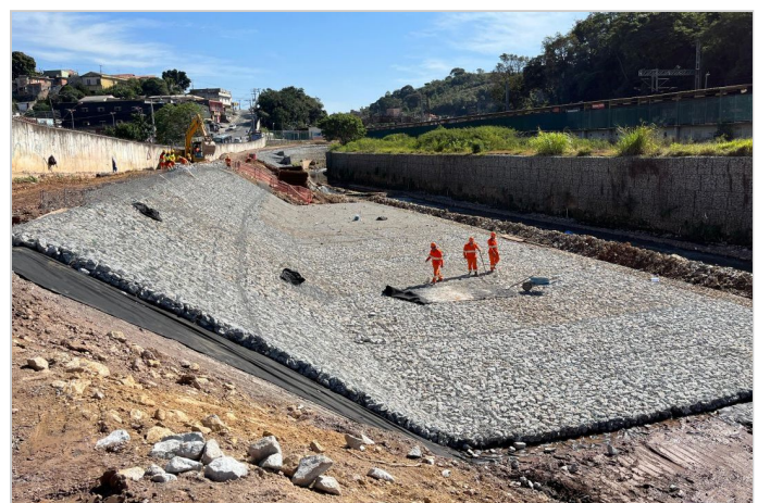
Durante a obra
