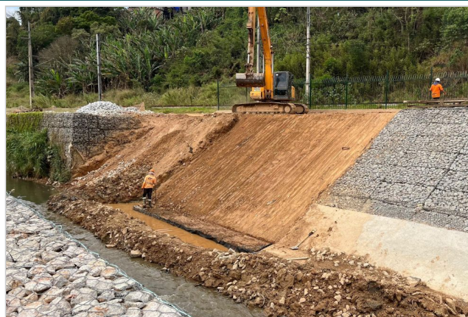
Durante a obra
