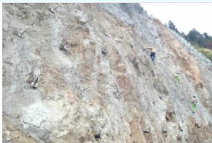
Durante la Obra
