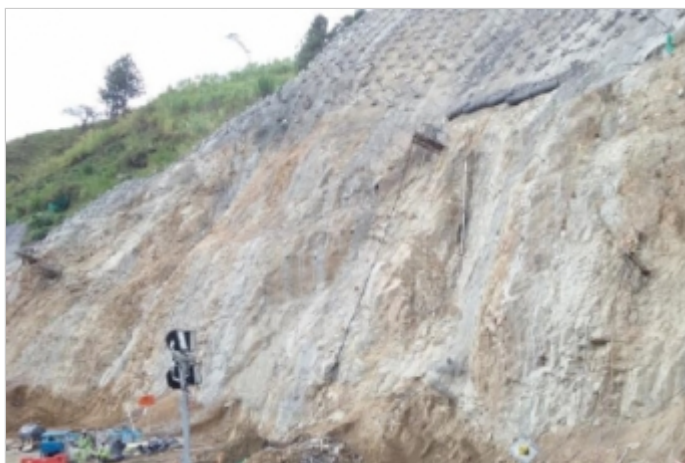
Durante la Obra
