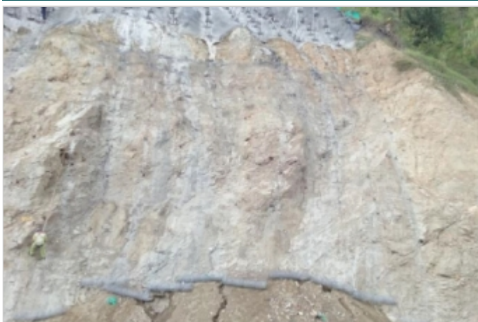
Durante la Obra
