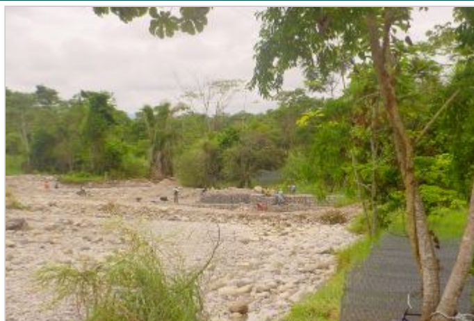
Durante la Obra
