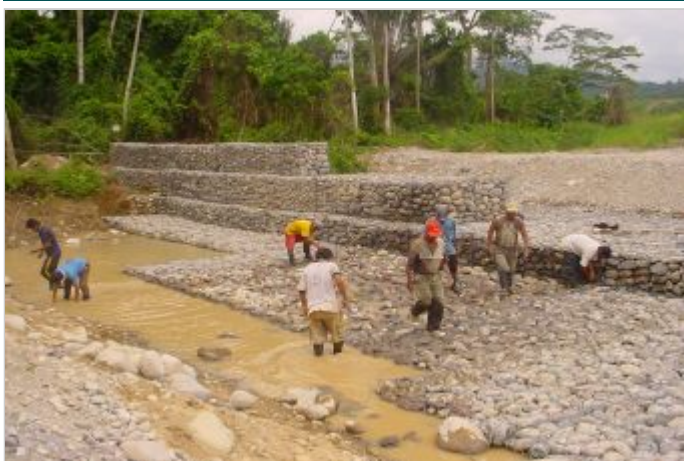
Durante la Obra
