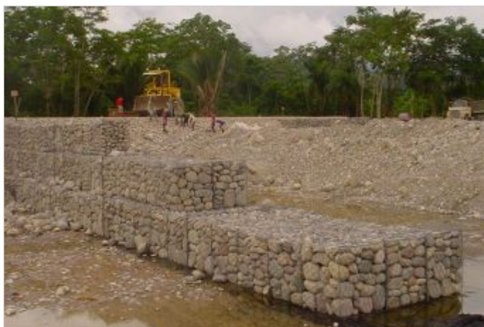
Durante la Obra
