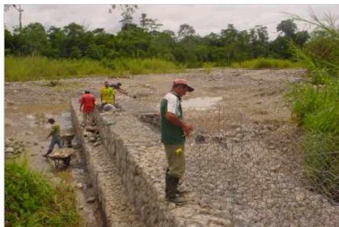
Durante la Obra
