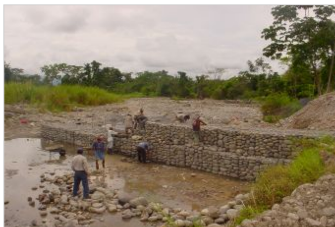
Durante la Obra
