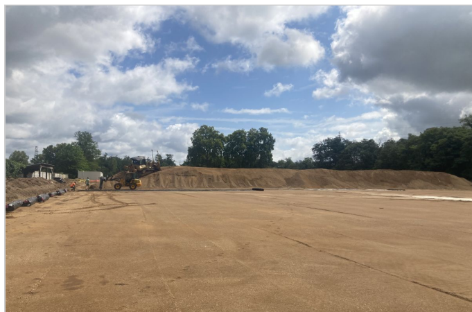
Géo grille prête à être déroulée sur fond de forme nivelé et compacté
