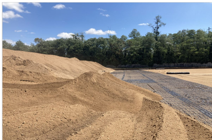
Mise en œuvre des matériaux sur la géo grille
