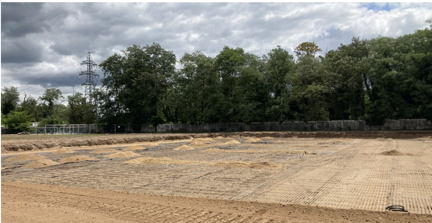
Géogridle installée transversalement au stade
