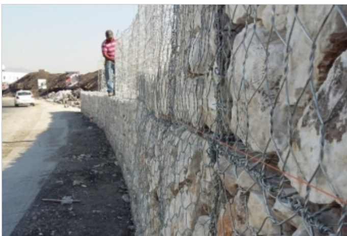
Durante la Obra
