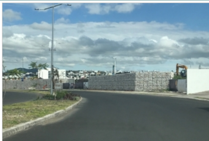
Durante la Obra
