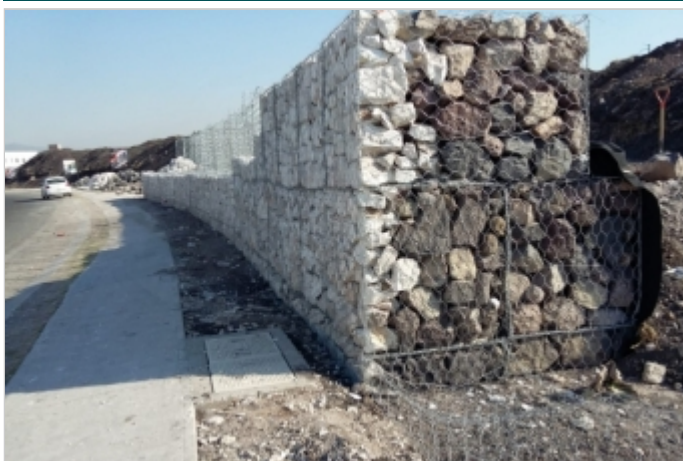
Durante la Obra
