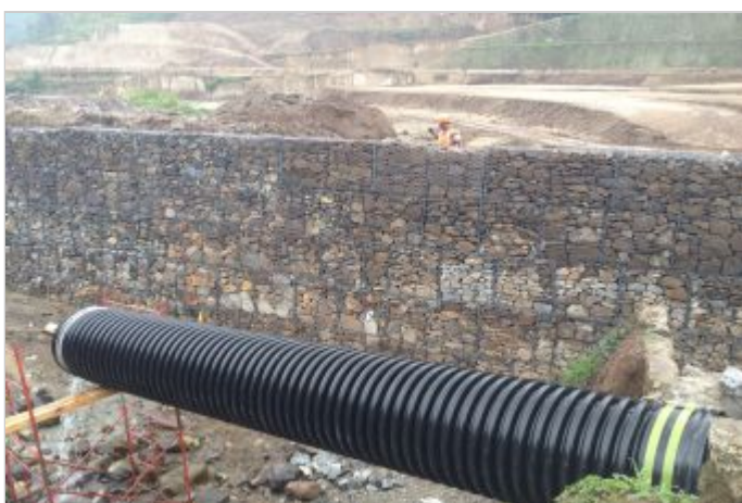
Durante la Obra
