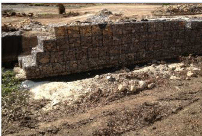
Durante la Obra
