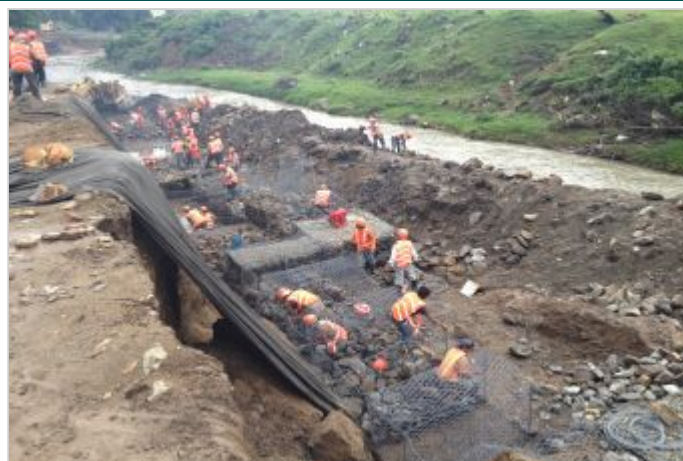
Durante la Obra
