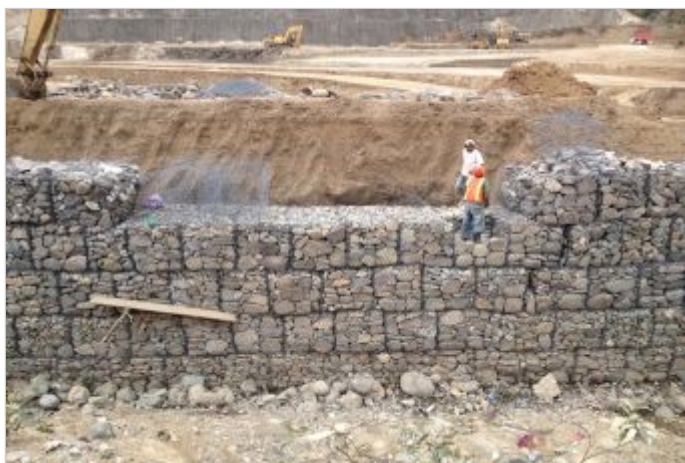
Durante la Obra
