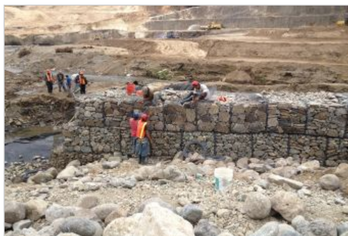
Durante la Obra
