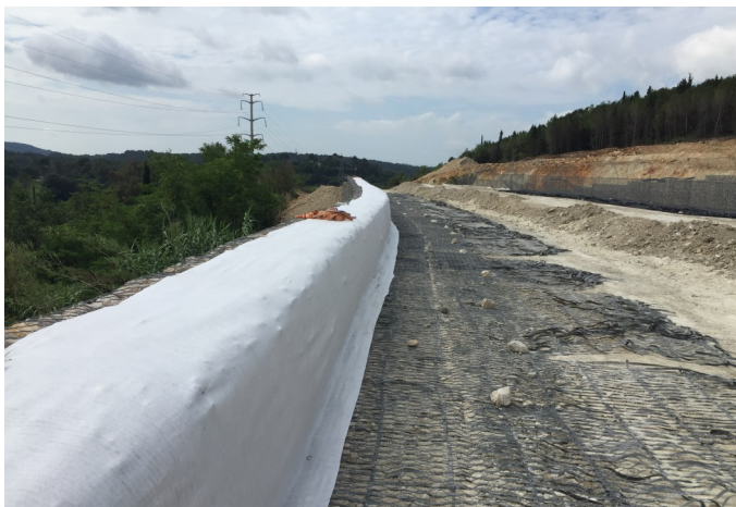
Mise en place de la solution - TerraMesh et ParaGrid
