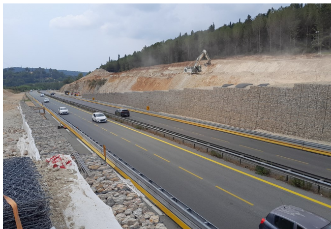
Bretelle Sud-Ouest durant les travaux
