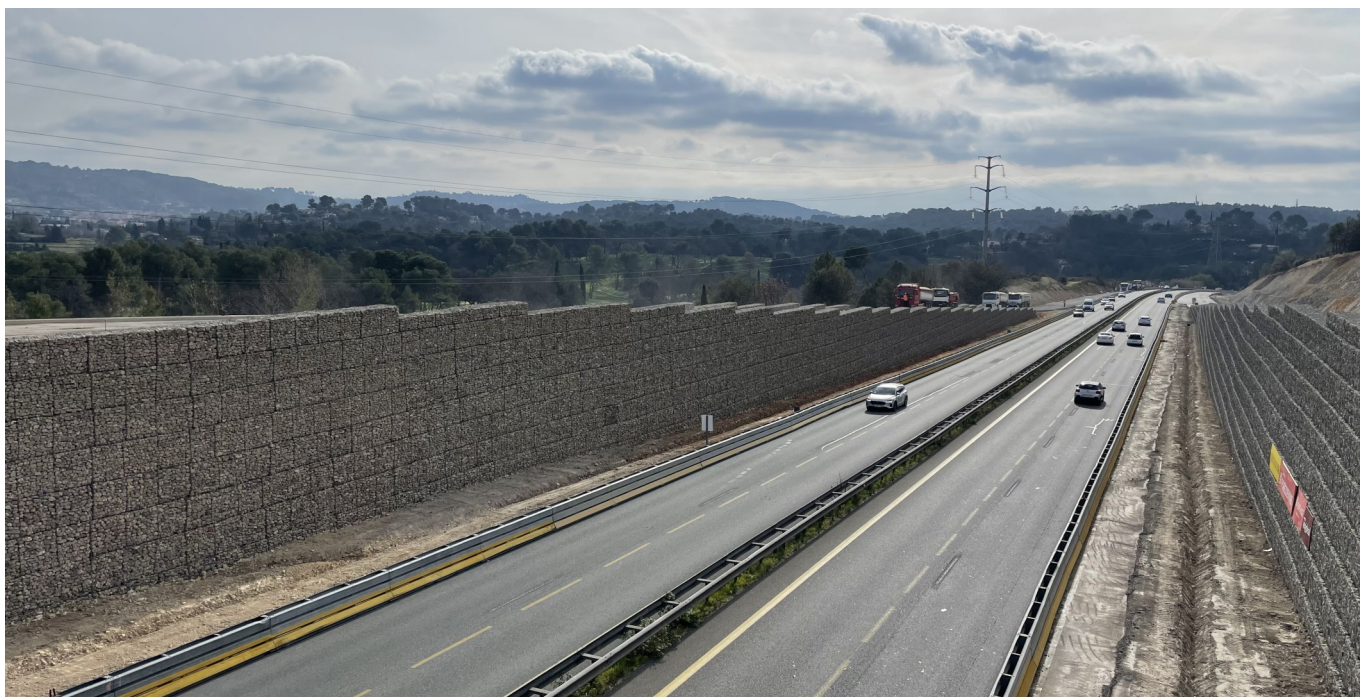
Vue par-dessus l'ouvrage
