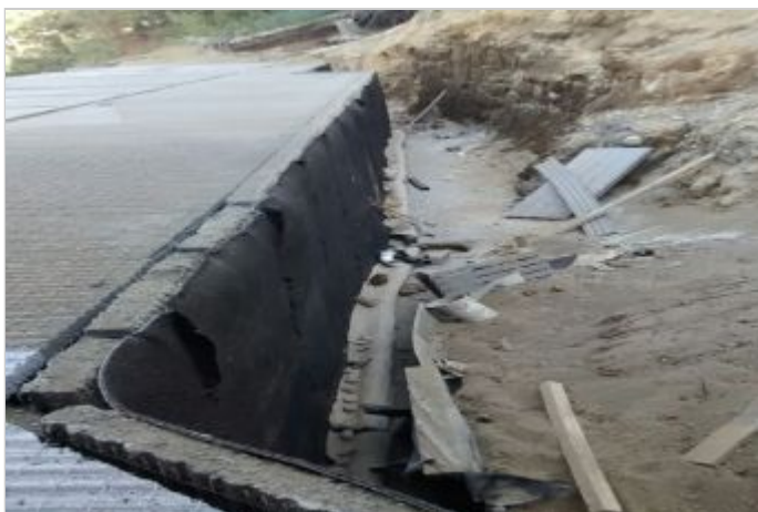
Durante a obra
