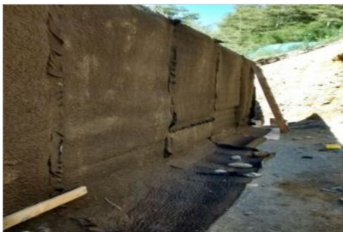
Durante a obra
