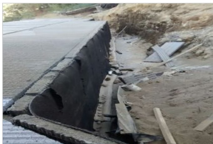
Durante a obra
