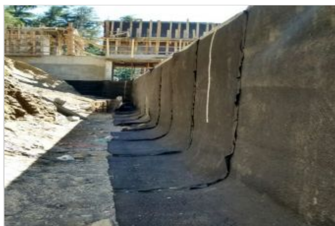
Durante a obra
