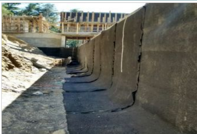
Durante a obra
