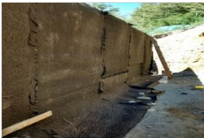
Durante a obra
