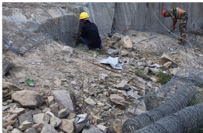
下支撑绳及锚杆施工
