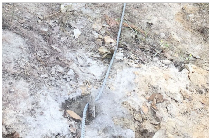
上支撑绳及锚杆
