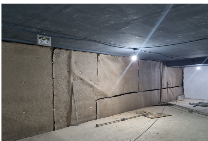
Durante a obra
