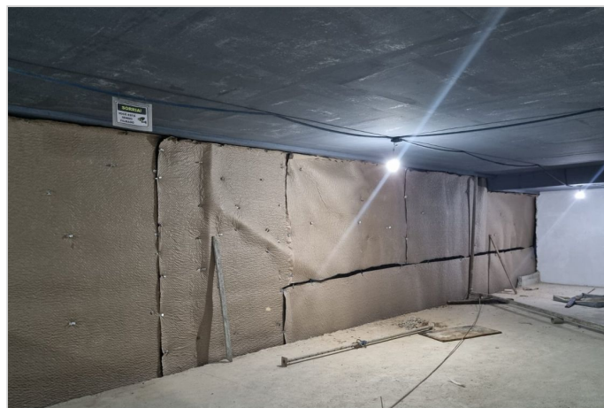
Durante a obra
