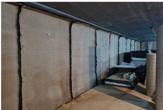
Durante a obra
