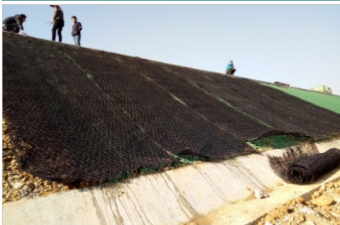
加筋麦克垫施工2016. 2
