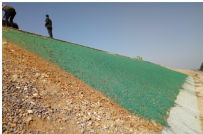
覆土及喷播施工2016. 2
