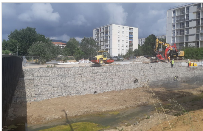
Mise en œuvre des gabions par les équipes Maccaferri
