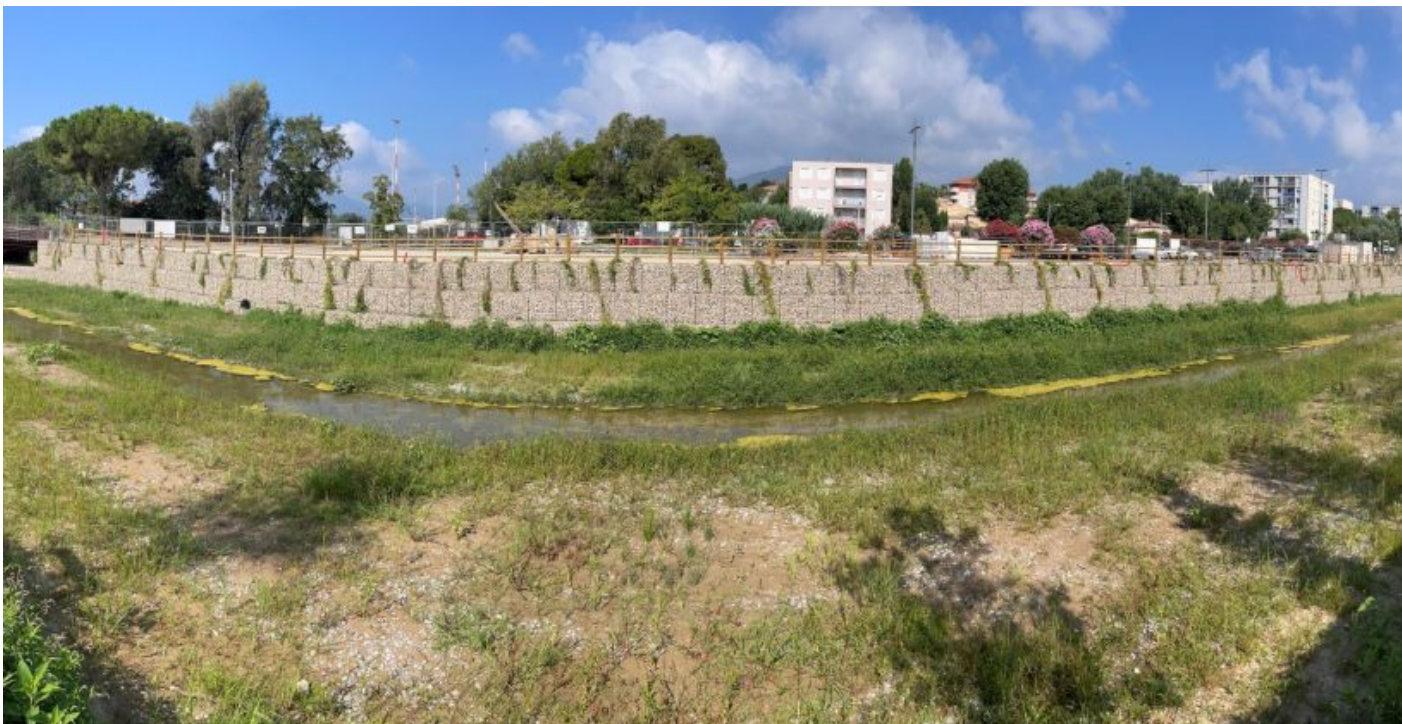
Réaménagement des berges - chantier fini
