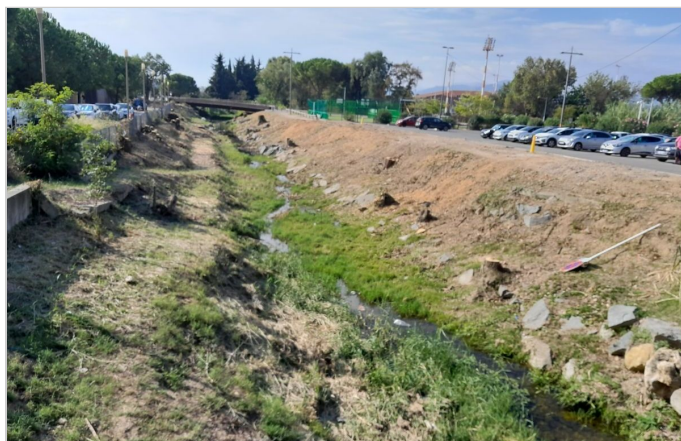
Cours d'eau La Frayère avant les travaux
