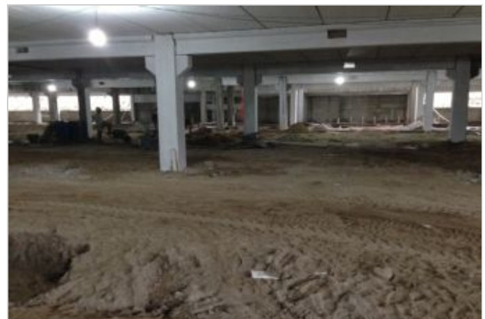
Durante a obra
