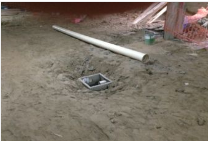
Durante a obra
