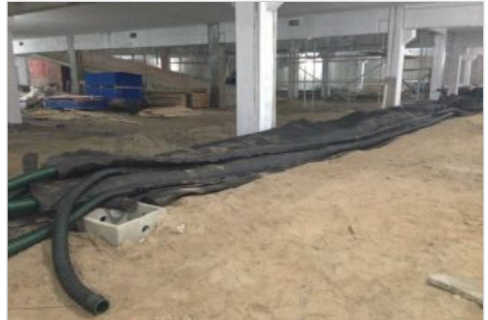
Durante a obra
