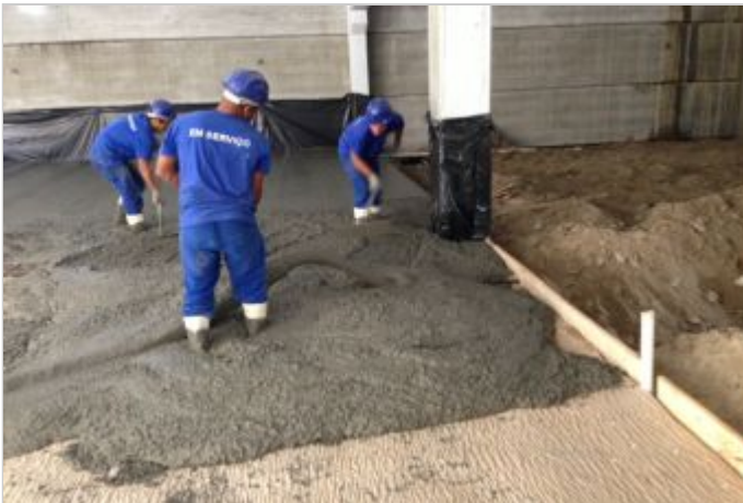
Durante a obra
