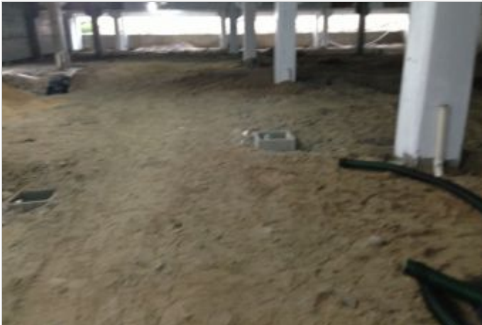
Durante a obra
