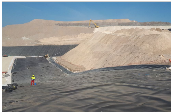
Instalación de la lámina de PEAD en los taludes
