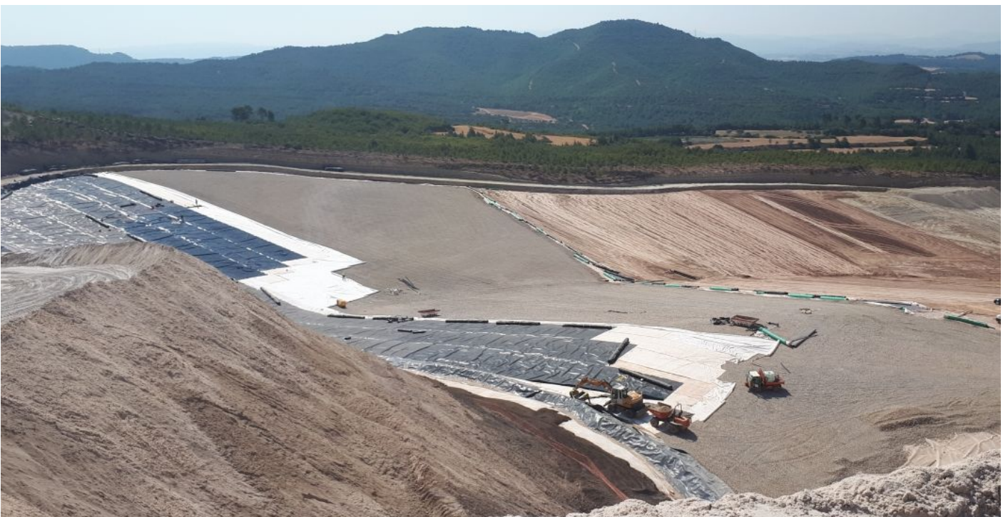
Vista general del depósito durante los trabajos
