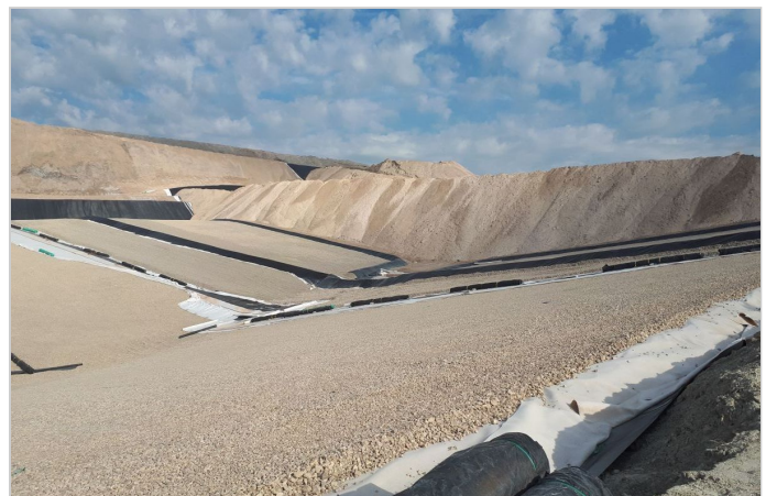
Vista general del depósito al inicio de los trabajos
