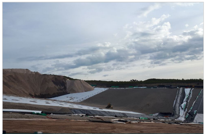
Detalle de instalación de la última barrera de impermeabilización
