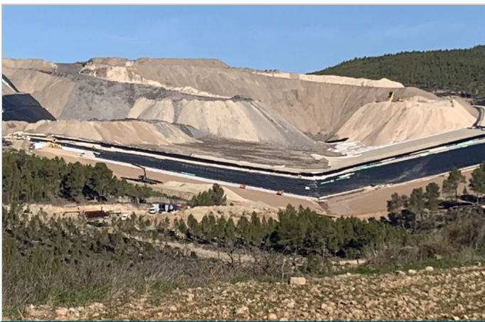
Detalle del fondo de valle del depósito
