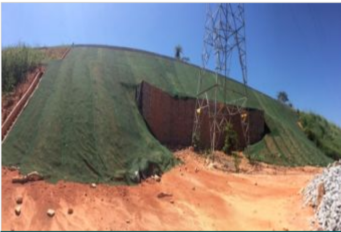
Durante a obra
