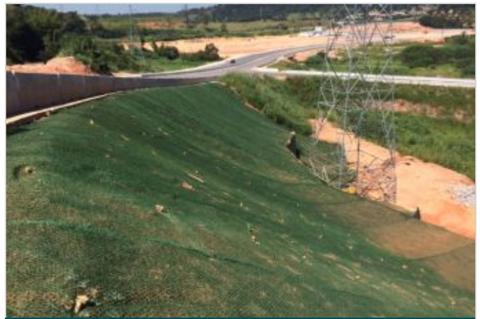
Durante a obra
