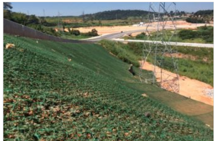
Durante a obra
