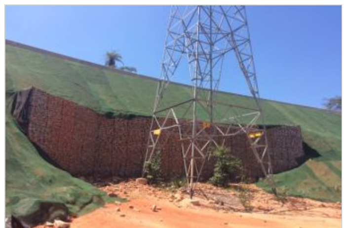
Durante a obra
