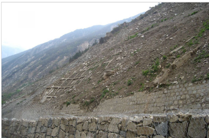
原状坡面情况
