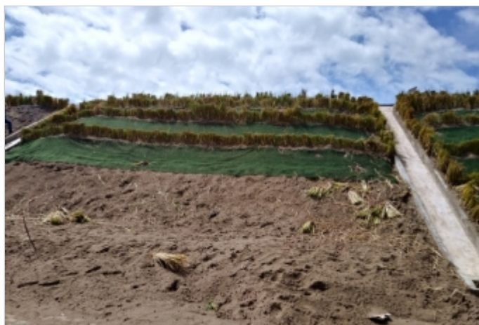
Durante la Obra
