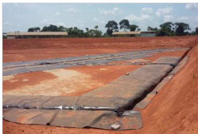
Durante a obra
