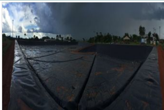
Durante a obra
