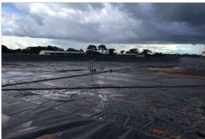
Durante a obra
