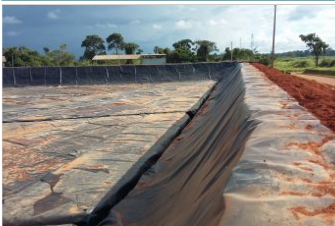
Durante a obra
