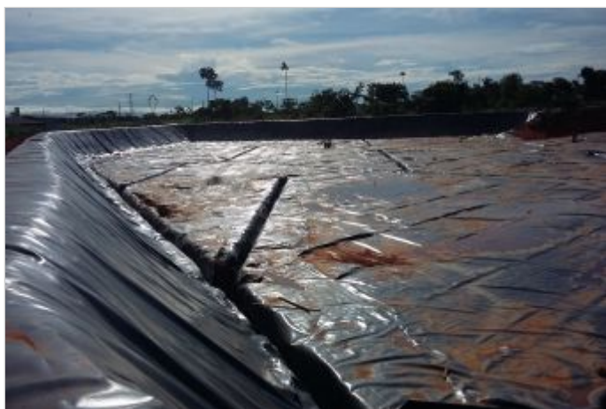
Durante a obra
