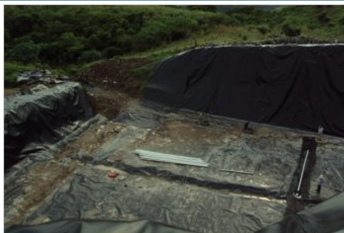
Durante a obra
