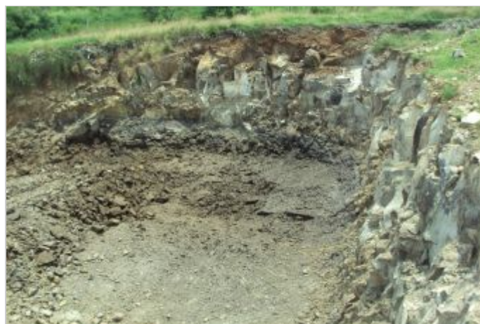
Antes da Obra
