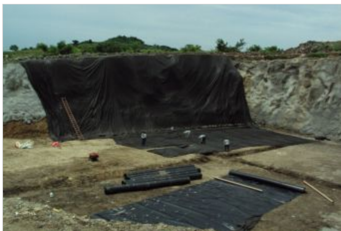
Durante a obra
