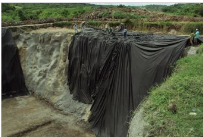
Durante a obra
