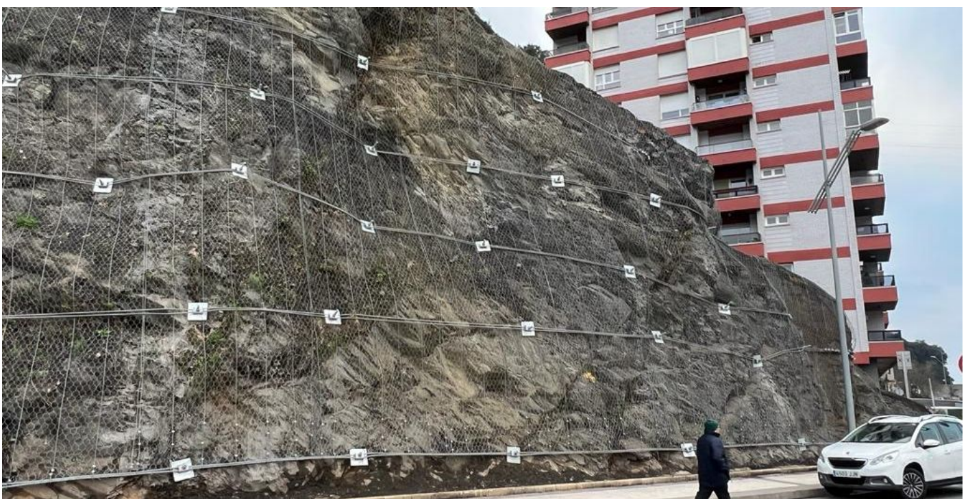
Vista general de la obra
