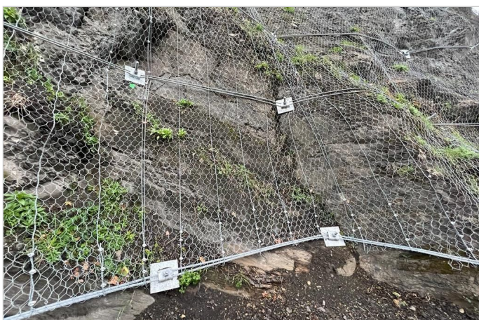
Detalle placas de anclaje
