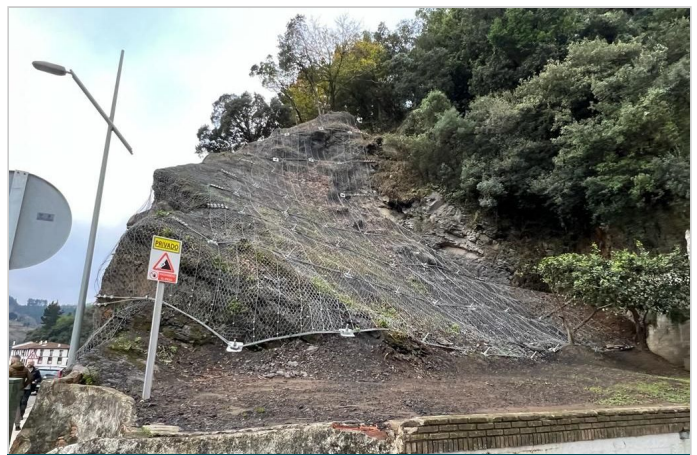
Vista talud lateral
