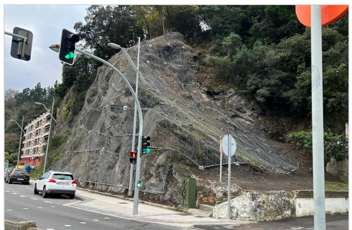
Taludes frontal y lateral
