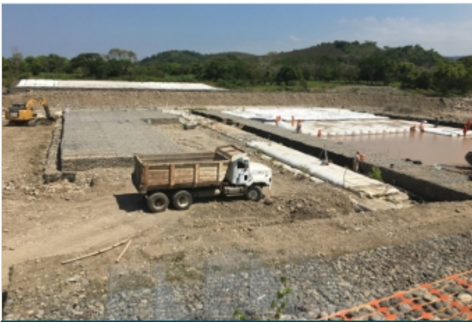
Durante a obra
