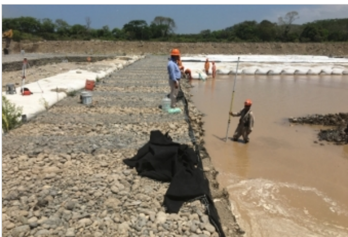
Durante a obra
