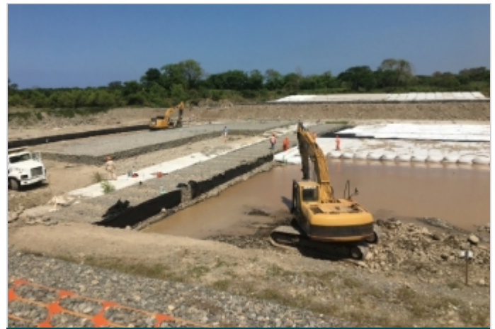
Durante a obra
