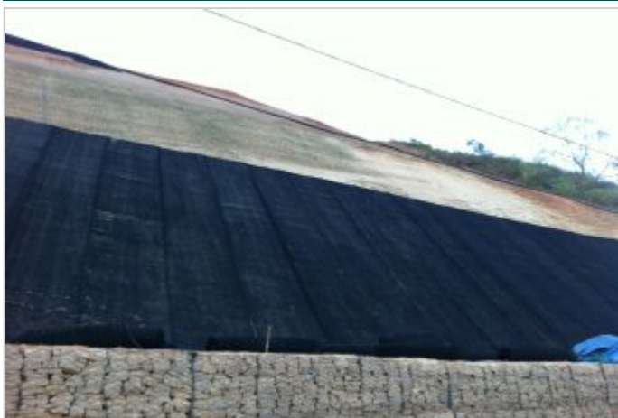
Durante la Obra
