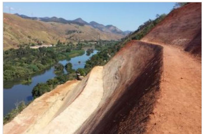
Durante la Obra
