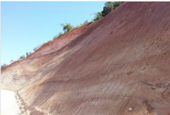
Durante la Obra
