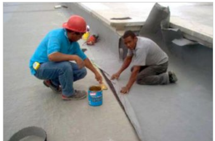
Durante la Obra
