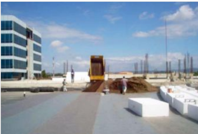
Durante la Obra
