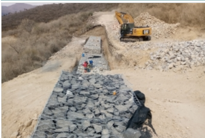
Durante la Obra
