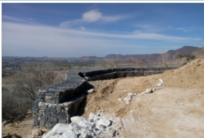
Durante la Obra
