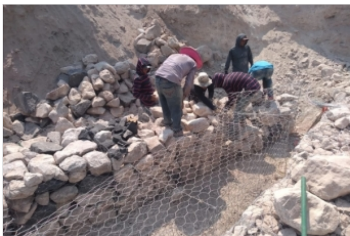
Durante la Obra
