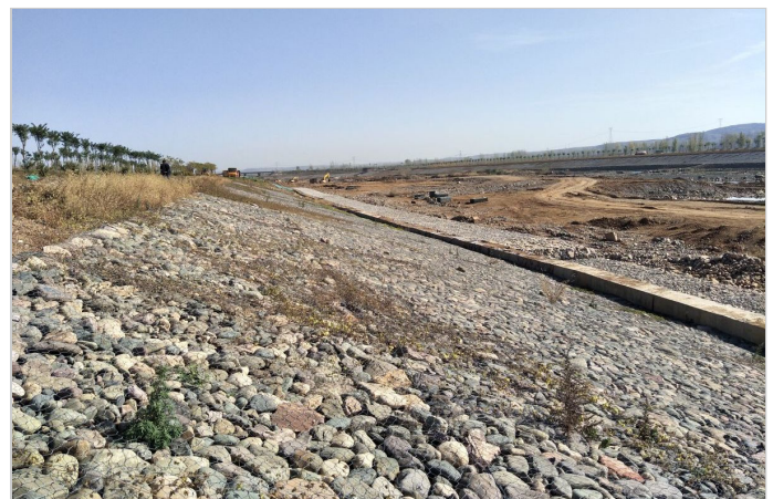
施工后两个月
