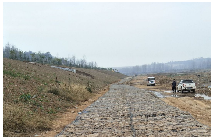
施工完两个多月后
