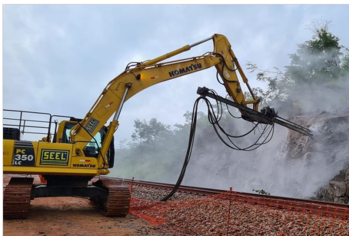
Durante a obra
