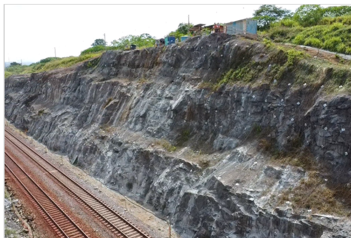
Durante a obra
