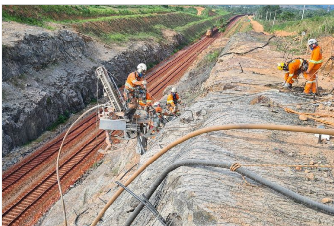
Durante a obra
