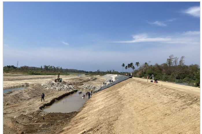
Durante la Obra
