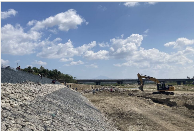
Durante la Obra
