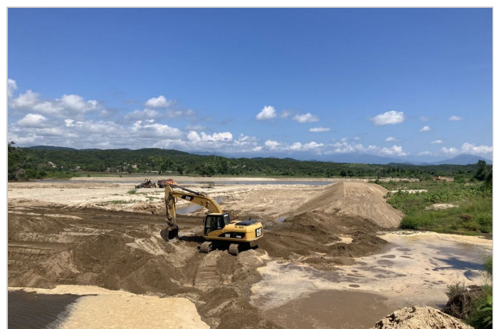
Durante la Obra
