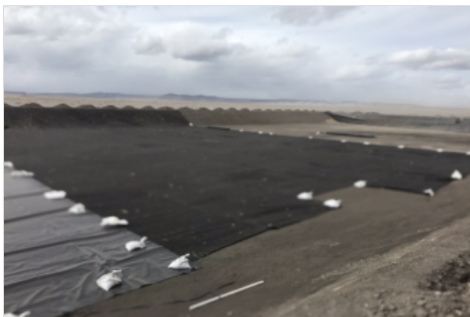
Durante la Obra
