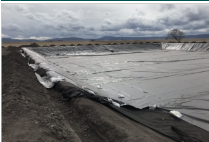
Durante la Obra
