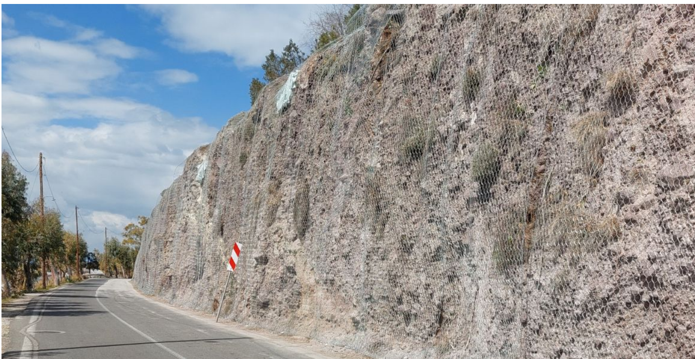
ΕΠΕΝΔΥΣΗ ΠΡΑΝΟΥΣ ΜΕ ΕΛΕΥΘΕΡΟ ΠΛΕΓΜΑ STEELGRID MO-300
