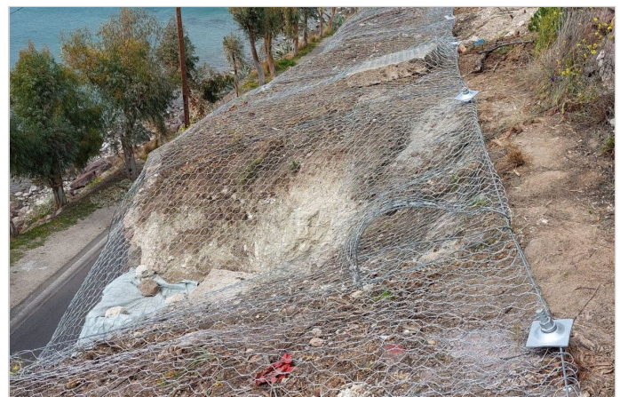
ΤΟΠΟΘΕΤΗΣΗ STEELGRID MO-300 ΣΤΗΝ ΣΤΕΨΗ ΤΟΥ ΠΡΑΝΟΥΣ
