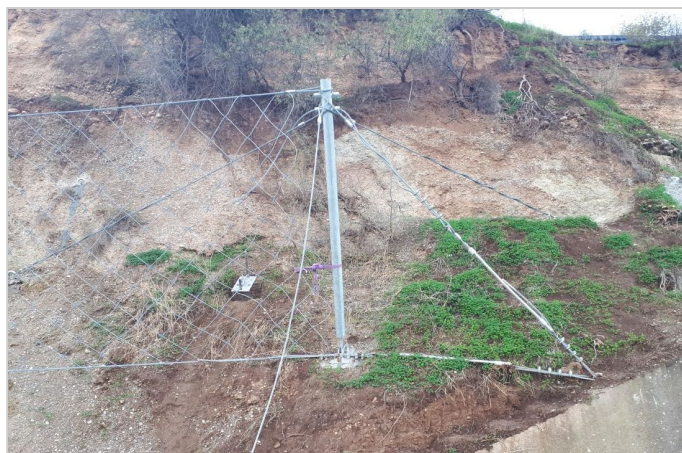
ΣΥΝΔΕΣΜΟΛΟΓΙΑ ΑΚΡΑΙΟΥ ΟΡΘΟΣΤΑΤΗ ΦΡΑΚΤΗ RB 750
