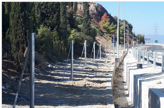
ΟΡΘΟΣΤΑΤΕΣ ΦΡΑΚΤΗ ΑΝΑΣΧΕΣΗΣ ΒΡΑΧΟΠΤΩΣΕΩΝ RB 100 UAF
