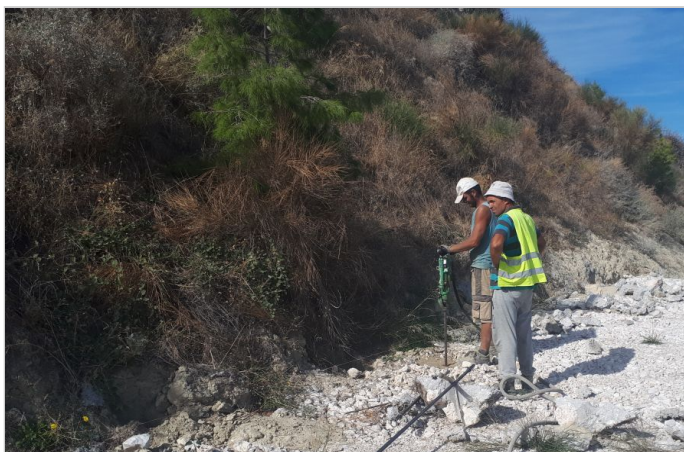
ΕΡΓΑΣΙΕΣ ΔΙΑΤΡΗΣΗΣ ΓΙΑ ΤΗΝ ΤΟΠΟΘΕΤΗΣΗ ΤΩΝ ΑΓΚΥΡΙΩΝ
