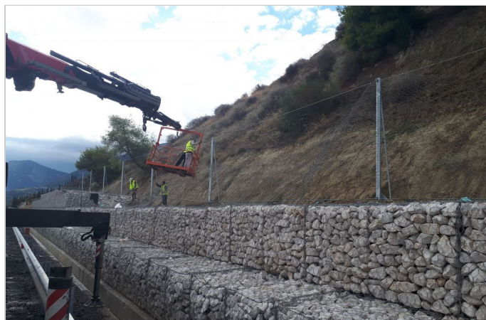
ΦΡΑΚΤΗΣ ΑΝΑΣΧΕΣΗΣ ΒΡΑΧΟΠΤΩΣΕΩΝ RB 100 UAF ΚΑΤΑ ΤΗΝ ΚΑΤΑΣΚΕΥΗ
