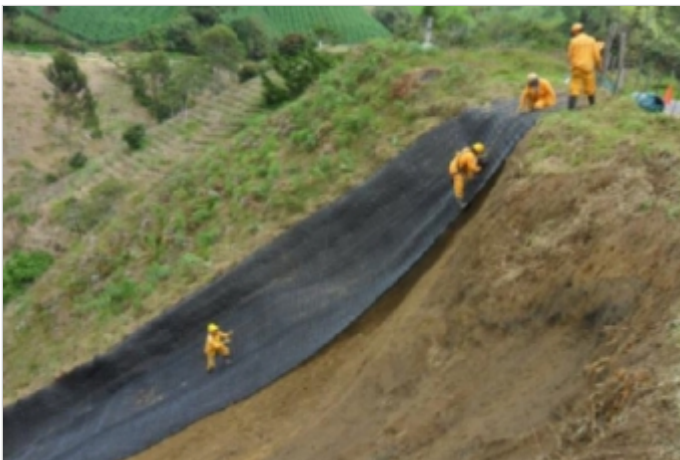
Durante la Obra
