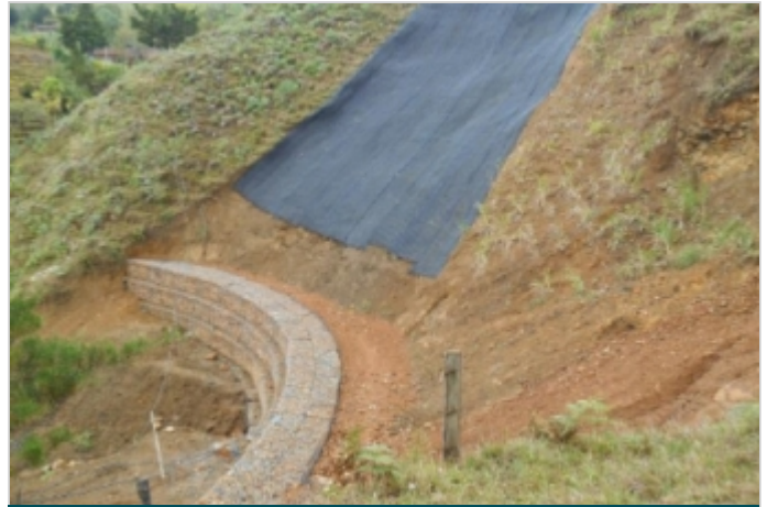
Durante la Obra
