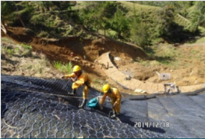
Durante la Obra
