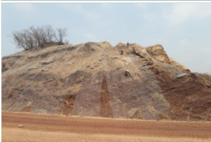
Durante la Obra
