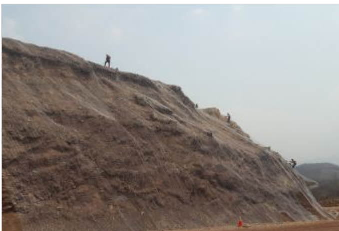
Durante la Obra
