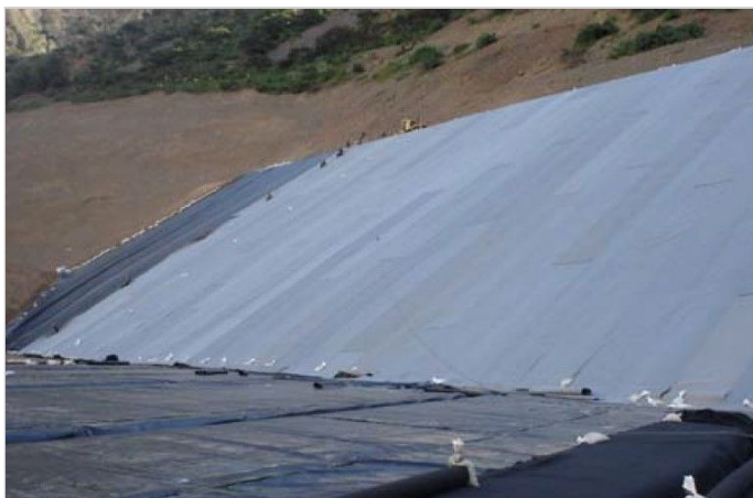
Instalación del MacDrain 2L en los taludes
