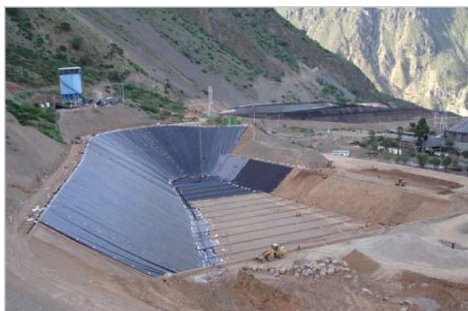
Impermeabilización del depósito
