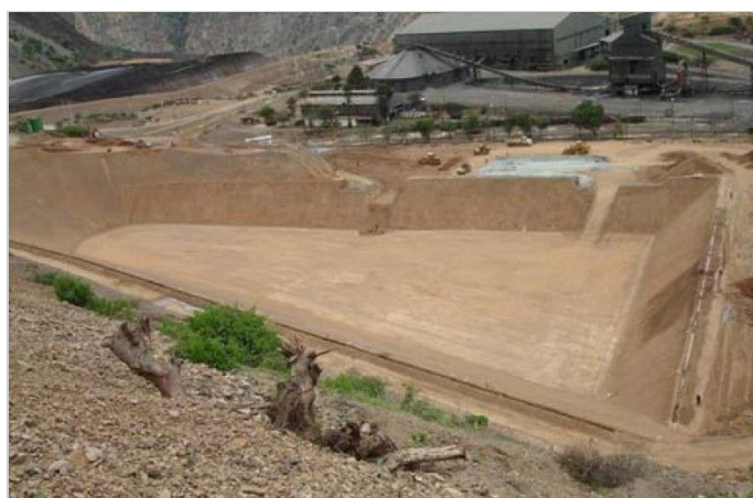
Excavación del depósito de relaves
