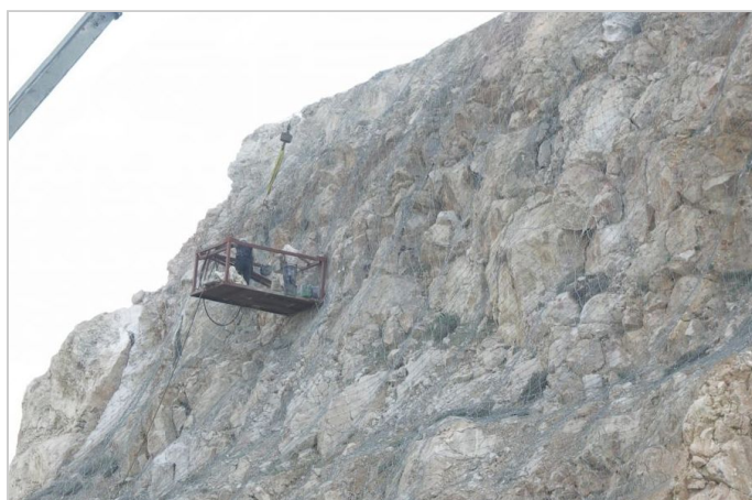
Πάνελ HEA κατά τη τοποθέτηση
