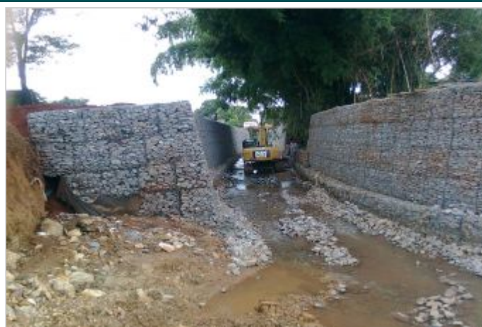
Durante la Obra
