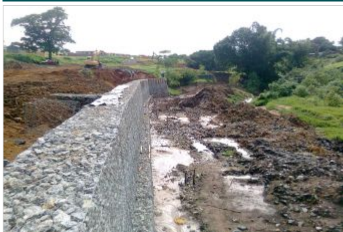
Durante la Obra
