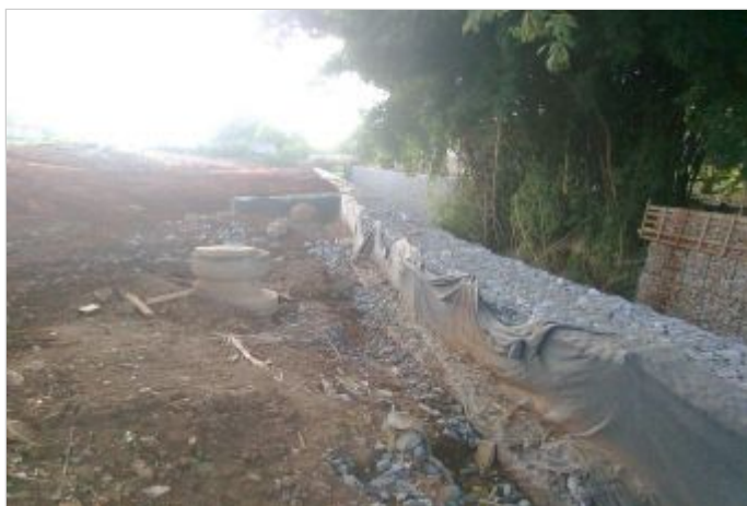
Durante la Obra
