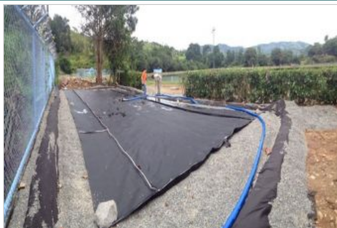
Durante a obra
