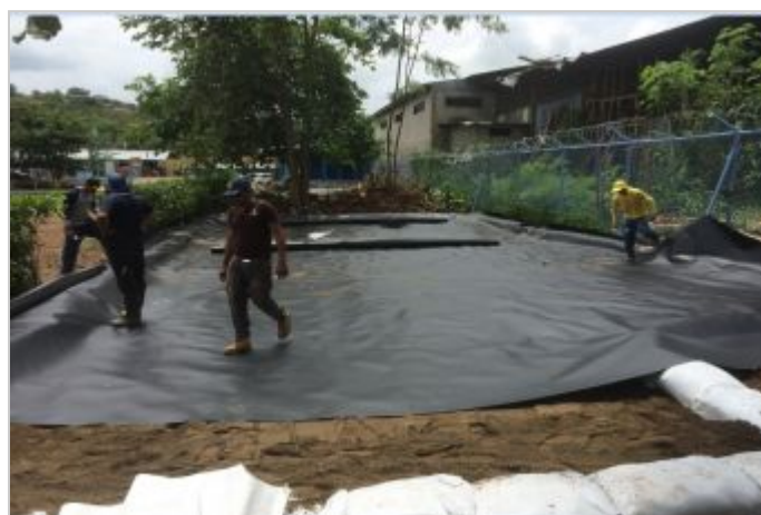
Durante a obra
