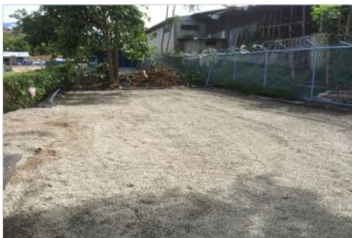
Durante a obra
