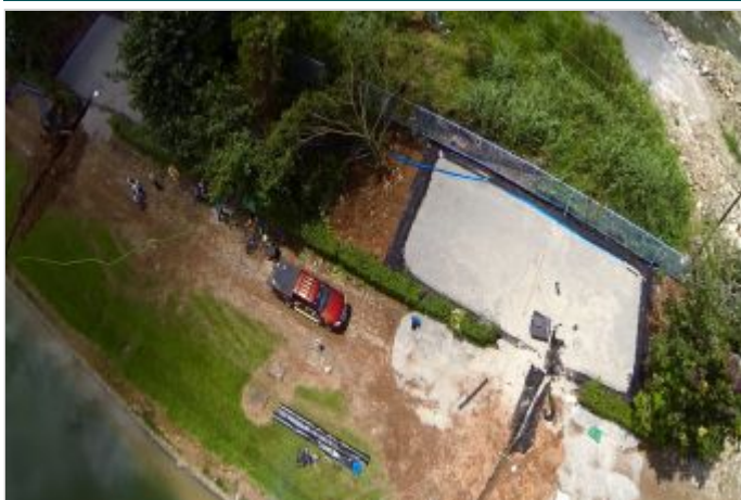
Durante a obra
